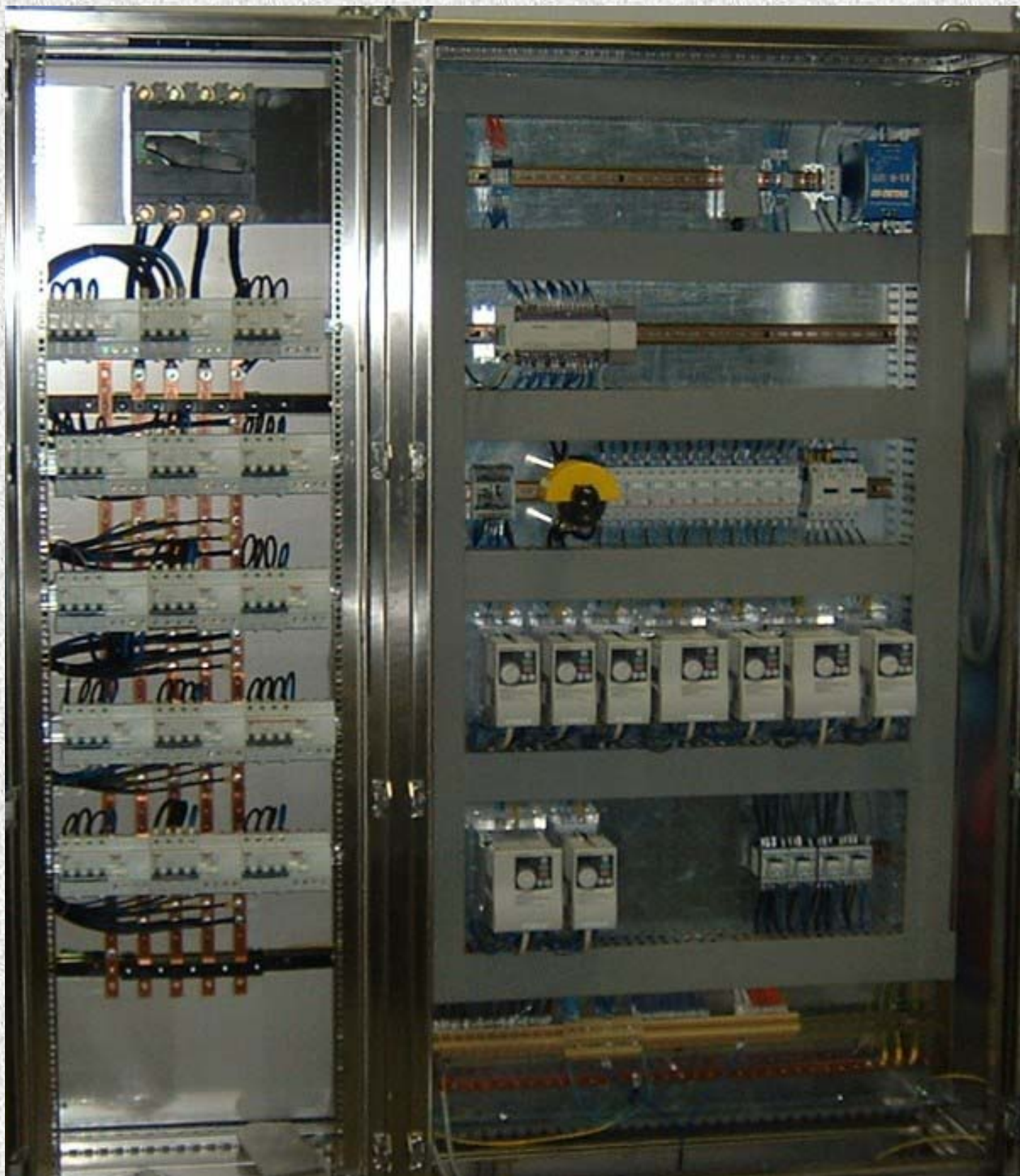
IMPIANTO GESTIONE LINEA DI IMBOTTIGLIAMENTO
